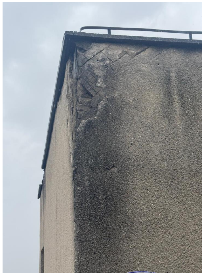
Figura 1: Degradări ale finisajului fațadei exterieioare.
