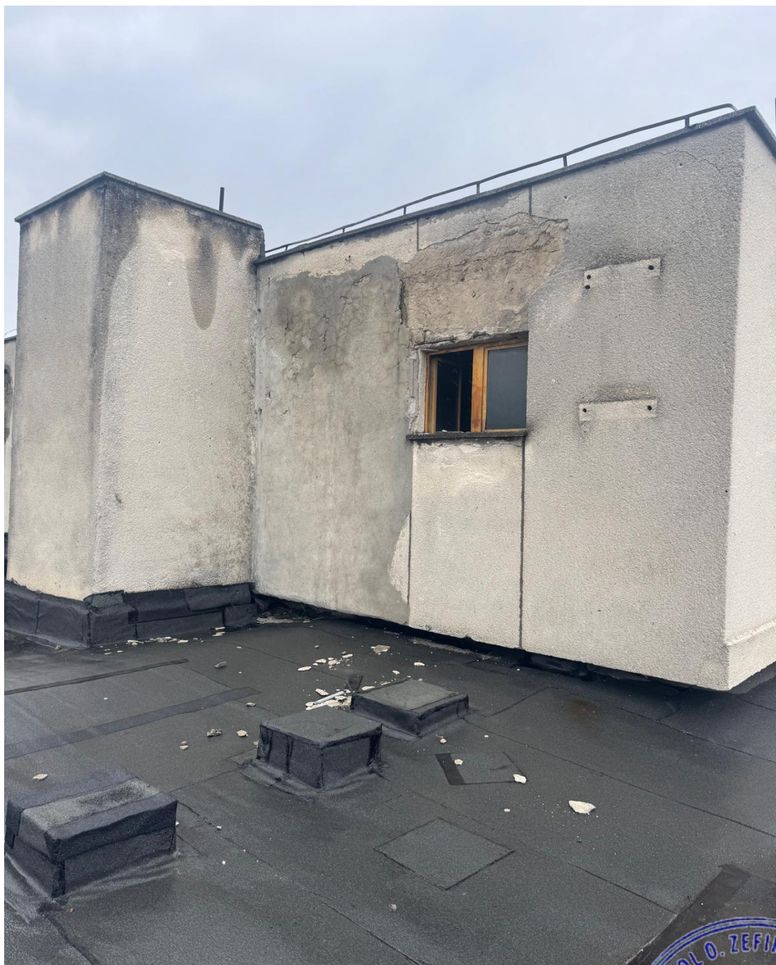
Figura 2: Degradări ale finisajului fațadei exterioare la iesirea de pe casa scării. Degradări ale hidroizolației terasei.
