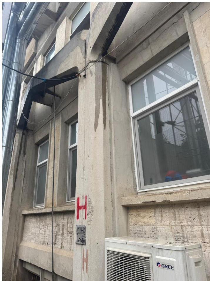
Figura 4: Infiltratii pe fatada cauzate de rezolvarea incorecta a aticului. Elementele prefabricate de fatada sunt descoperite in unele locuri, lasand astfel armatura expusa.
