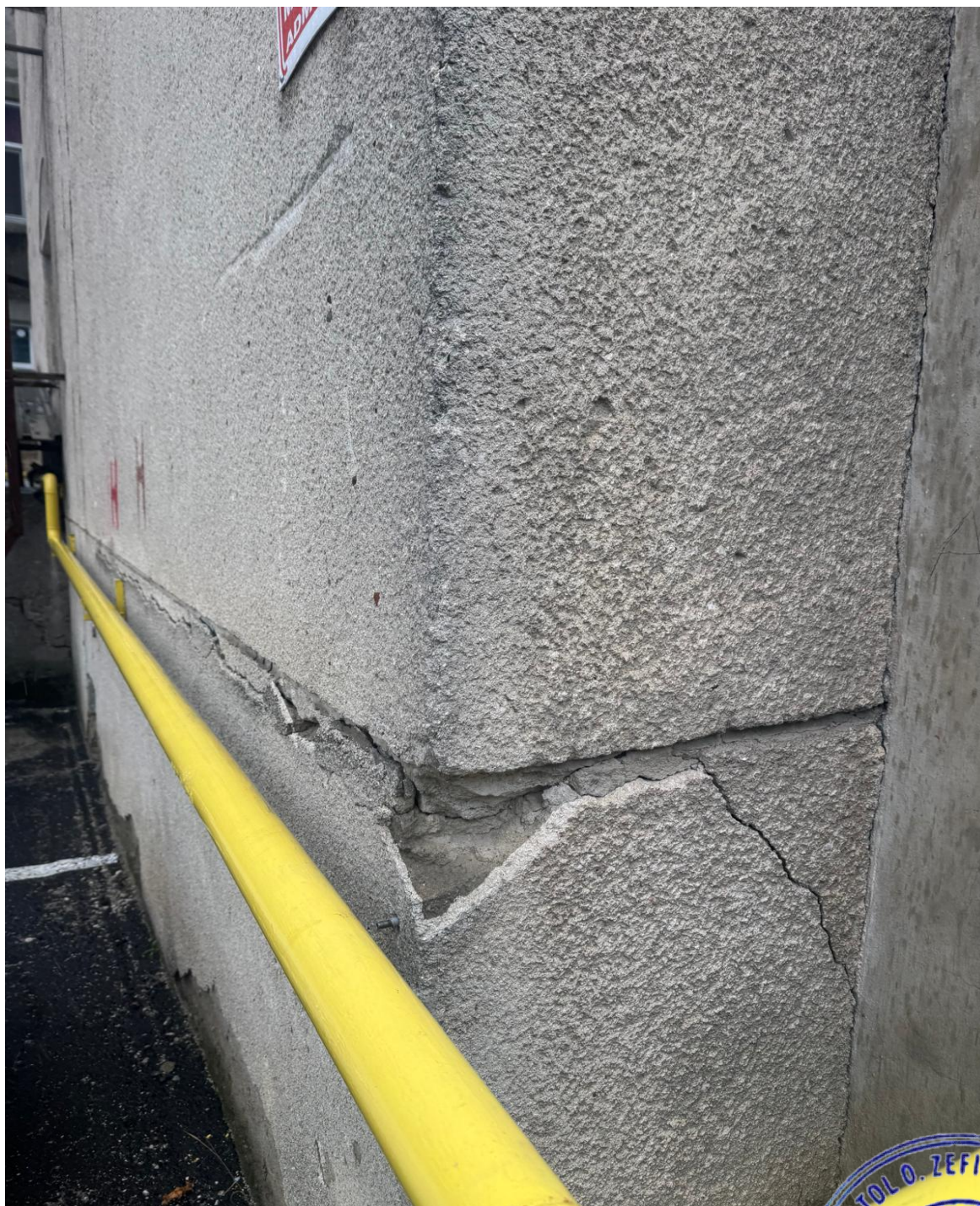
Figura 3: Degradări ale finisajului fațadei exterioare între soclu și planul fațadei. Fisura majoră de finisaj
