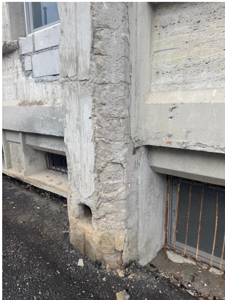
Figura 1: Degradări ale finisajului fațadei exterieioare.
