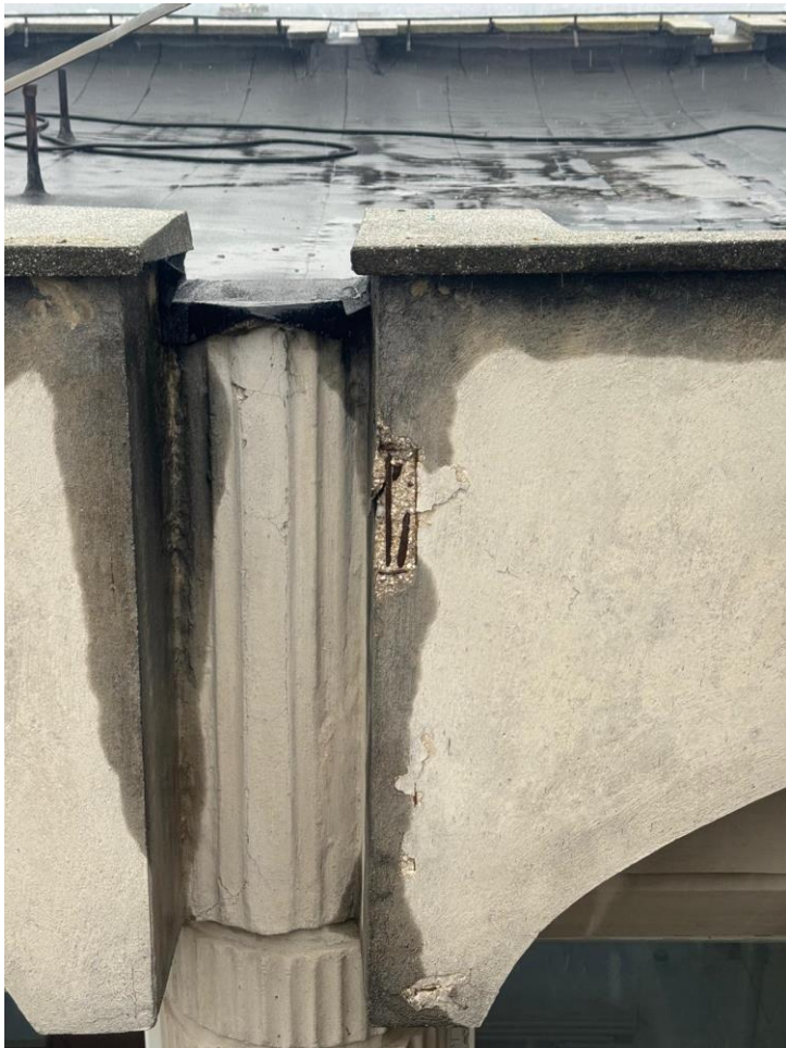
Figura 4: Infiltratii pe fatada cauzate de rezolvarea incorecta a aticului. Elementele prefabricate de fatada sunt descoperite in unele locuri, lasand astfel armatura expusa.
