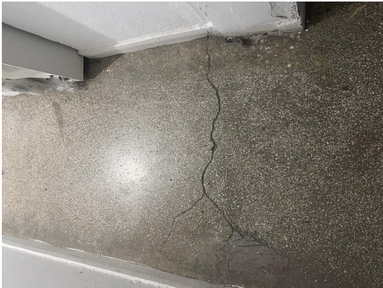
Figura 6: Fisura in pardoseala peste sol.
